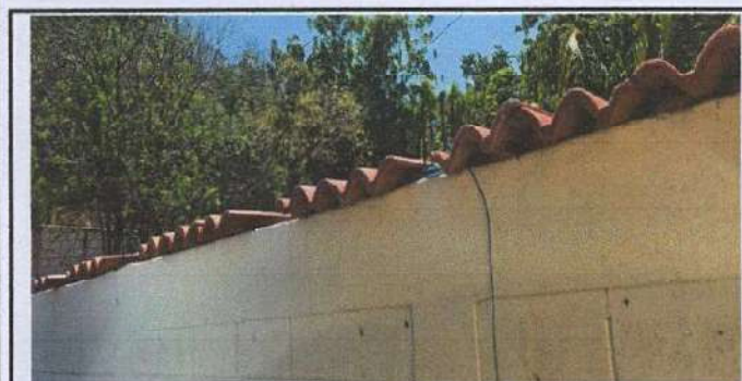
Foto 5: Sustrucción de teja en mal estado en muro perimetral, por teja nueva
