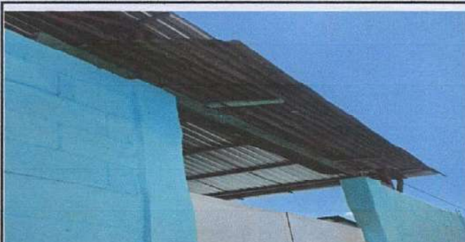
Foto 9: Sustitución de estructura de madera y lámina deteriorada en cubierta de portón.
