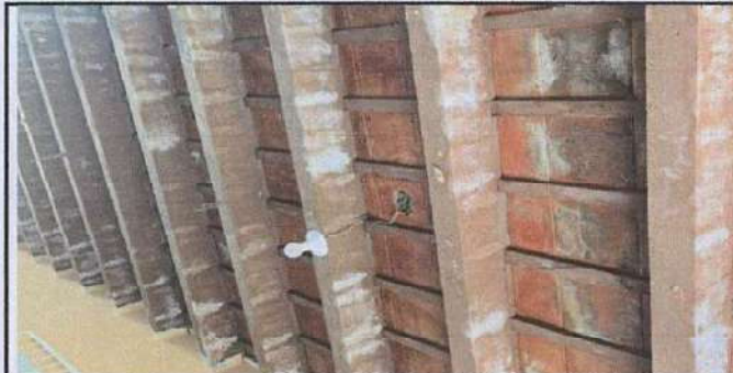
foto 10: Retoque de pintura en losa de corredor
